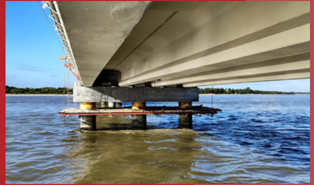
Figura 3. Curado y protección del CUAD
