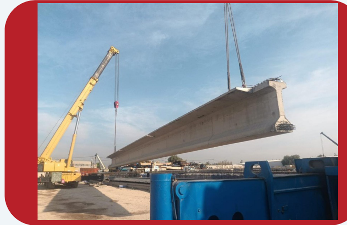
Figura 2. Descimbrado y movimiento de los elementos prefabricados.
